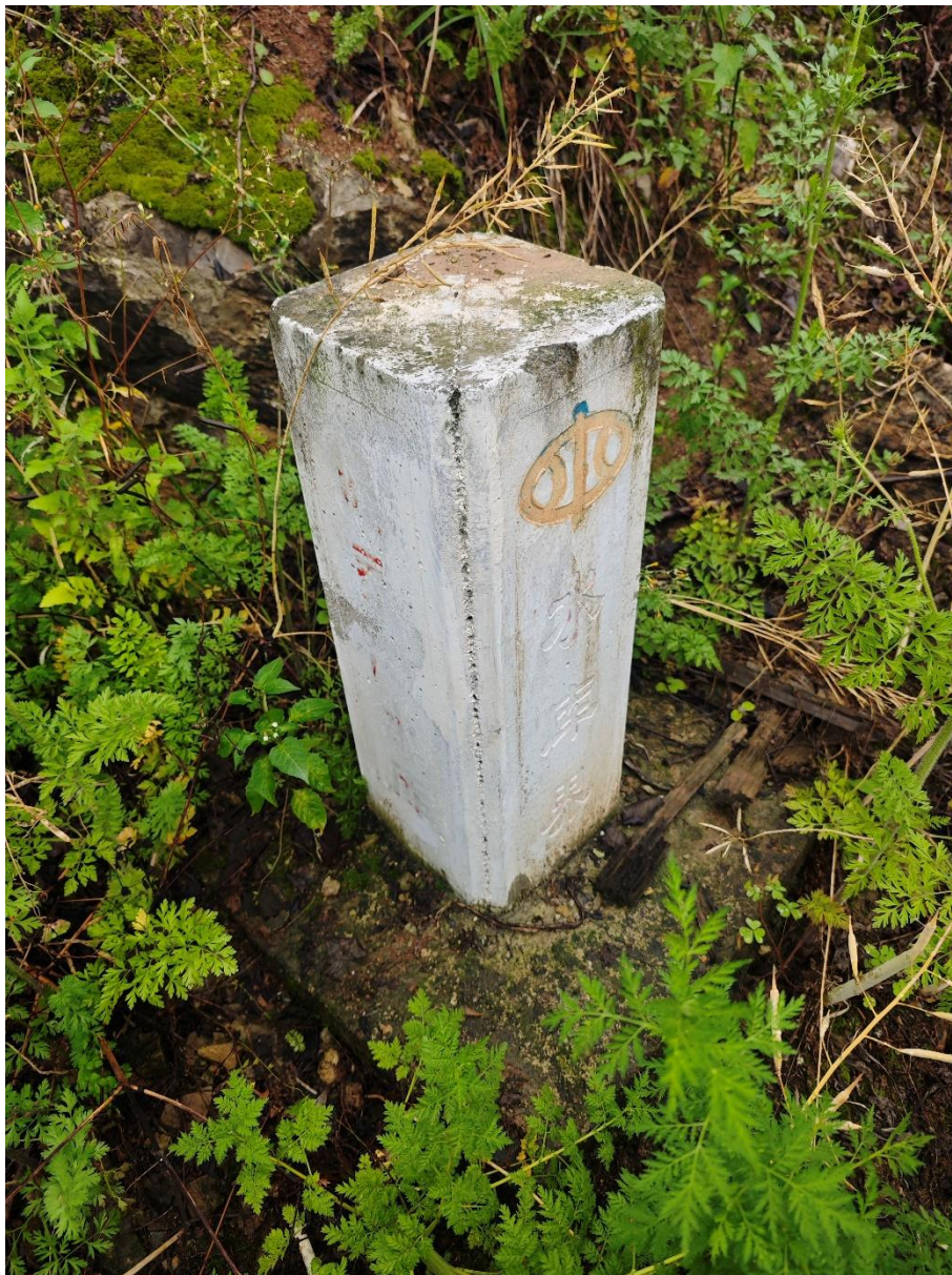
图 2.2-3 界桩油漆脱落、缺失
