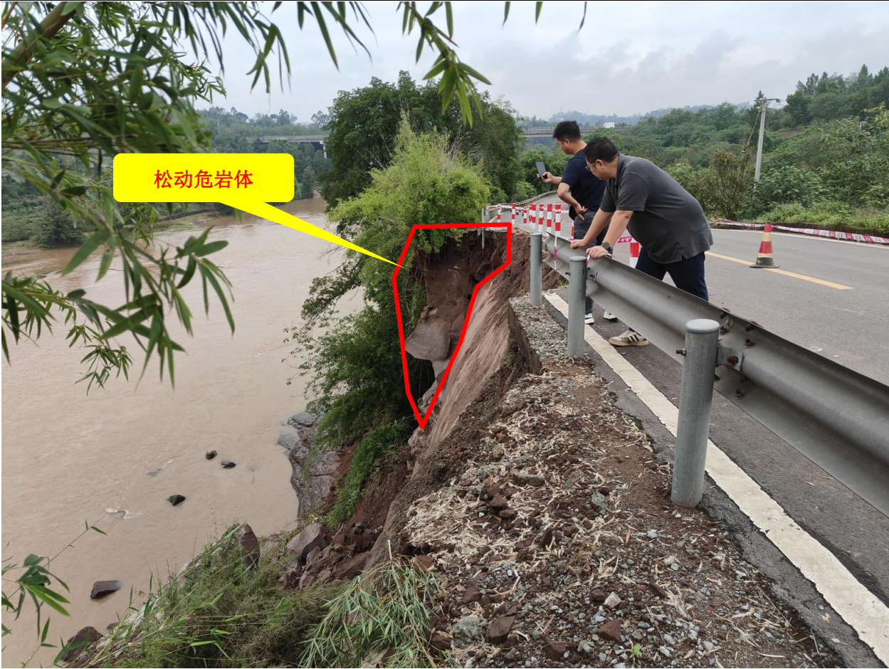
图1-5 外倾危岩体倾倒崩塌后现场照片
