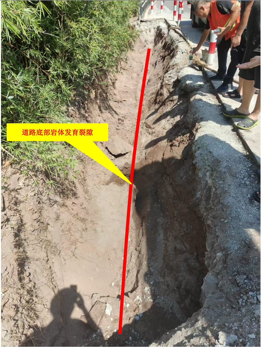
图1-4 道路底部岩体裂隙发育调查照片
